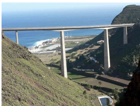
Puente de Silva situado en el norte de Gran Canaria.
